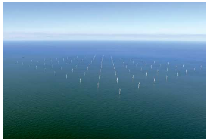
Meister der Energieernte auf dem Meer: Dänemark ist bei Offshore-Anlagen in Europa führend. Der Windpark „Horns Rev“ wurde 2002 vor der dänischen Südwestküste errichtet und hat eine Leistung von 160 Megawatt.
